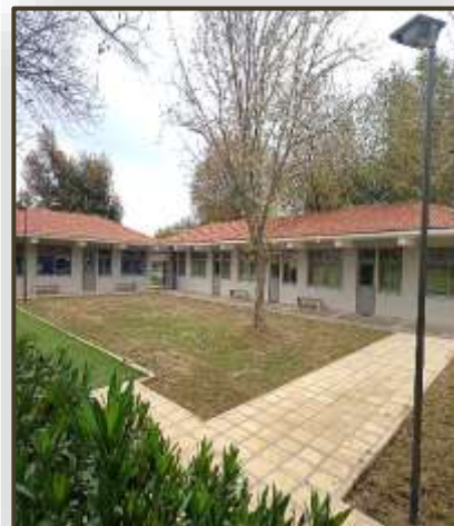
Εικόνα 47. Αύλειος χώρος (Ε.Ε.Ε.ΕΚ. Τρικάλων)
