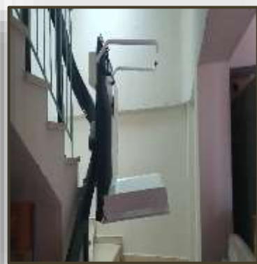
Εικόνα 97. Αναβατόριο κλίμακας με πλατφόρμα (Ε.Ε.Ε.ΕΚ. Άρτας)
