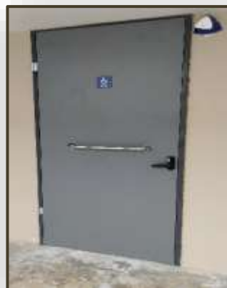
Εικόνα 182. Πόρτα με πόμολο και μπάρα (1° ΕΠΑ.Λ. Κέρκυρας)
