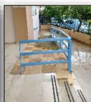
Εικόνα 10: Αντιολισθητικές λωρίδες στα σκαλοπάτια (1° ΕΠΑ.Λ. Σπάρτης)
