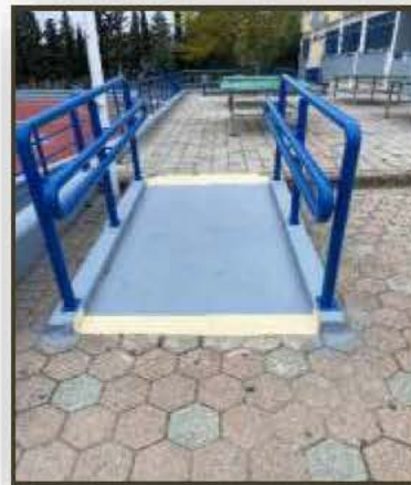
Εικόνα 17. Ράμπα με διπλούς χειρολισθήρες (5 ο Γυμνάσιο Ξάνθης)
