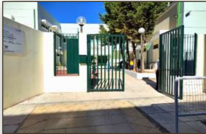
Εικόνα 3. Προσβάσιμη είσοδος σχολείου (Ειδικό Δημοτικό Ζεφυρίου)
