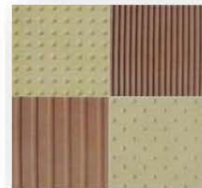
Εικόνα 21. Τα ειδικά πλακίδια του οδηγού τυφλών οδέυσης τυφλών βάσει της με αρ.52488/2001 Υπ. Απόφασης (Δημουλά, κ.ά., 2023)
