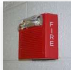
Εικόνα 62. Σύστημα ειδοποίησης πυρκαγιάς (Δημουλά, κ.ά., 2023)
