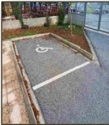
Εικόνα 28. Σήμανση πάρκινγκ ΑμεΑ (Ε.Ε.Ε.ΕΚ. Λάρισας)
